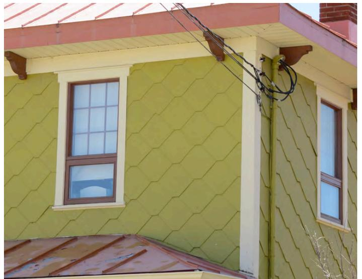
Portion du revêtement de bardeau d'amiante disposé en losanges du 25, rue de la Frontière Est, Rivière-Bleue. IMG\_2377.jpg
