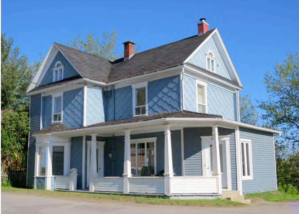
Revêtement de bardeau d'amiante disposé en losanges, en bonne partie conservé au 853, rue Commerciale Nord, Témiscouata-sur-le-Lac. IMG\_3651.jpg
