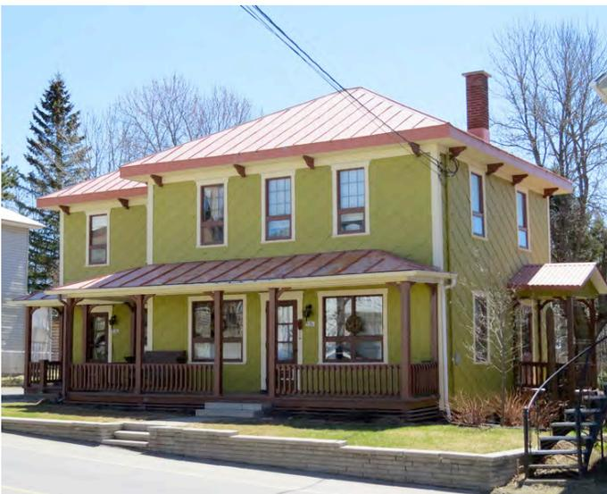
Autre exemple de revêtement de bardeau d'amiante disposé en losanges, un matériau d'origine, représentatif de l'époque de construction de l'édifice (début 20<sup>e</sup> siècle). 25, rue de la Frontière Est, Rivière-Bleue. IMG\_2376.jpg
