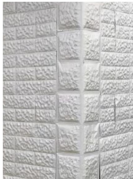
Détail d'une chaîne d'angle du revêtement de tôle embossée du 43, rue Caldwell, Témiscouata-sur-le-Lac. IMG\_1818.jpg
